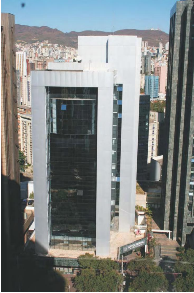
Edifício Euclides Reis Aguiar, na avenida Álvares Cabral 1741
