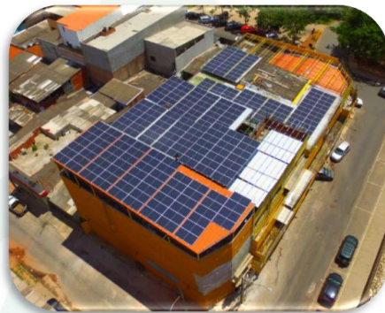
Comercial - ADE Sistema de 120 kWp
