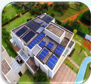
Residencial Lago Sul Sistema de 7,92 kWp
