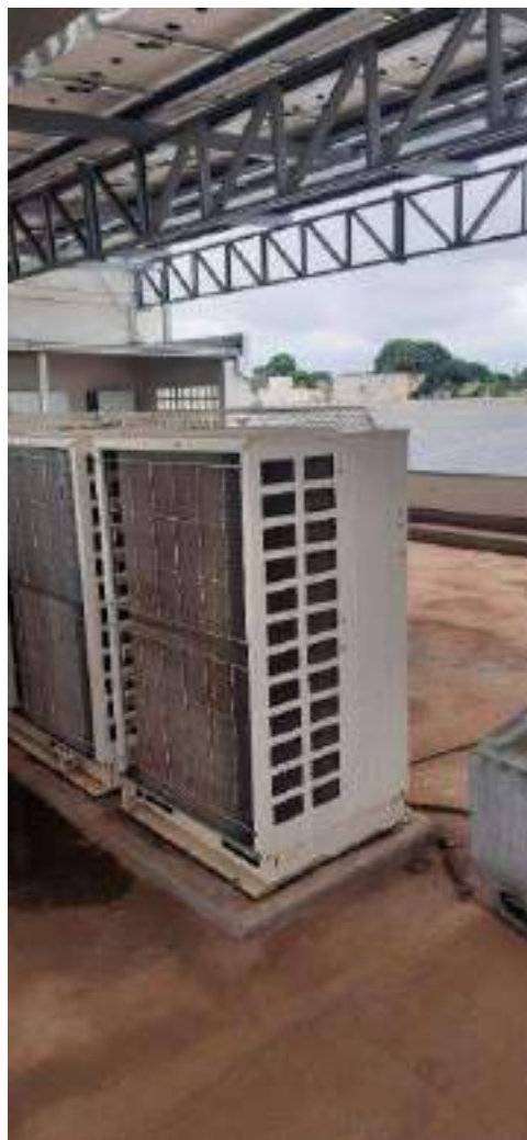
Local para instalação das condensadoras.
