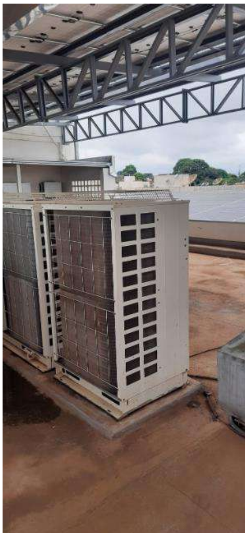
Local para instalação das condensadoras.
