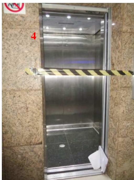
A FOTO acima mostra o elevador privativo(4)
