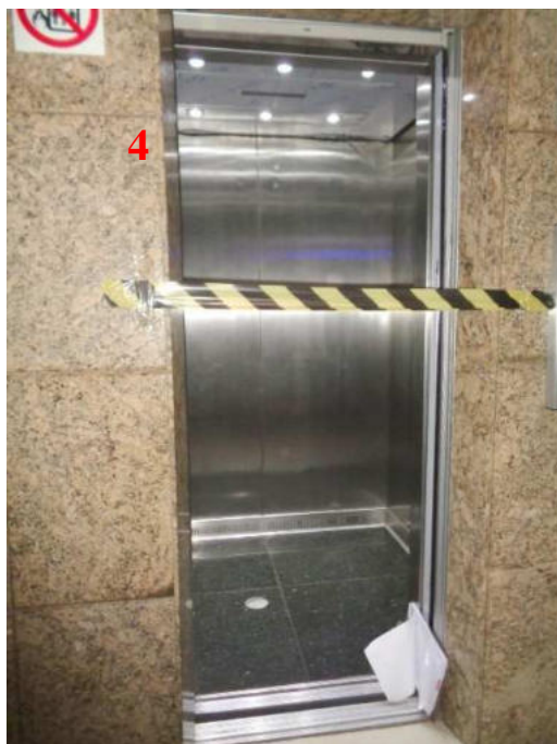
A FOTO acima mostra o elevador privativo
