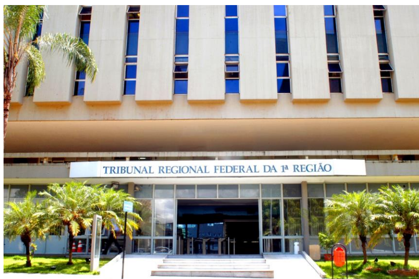
Fachada do edifício-sede I Crédito: Ascom/TRF1
